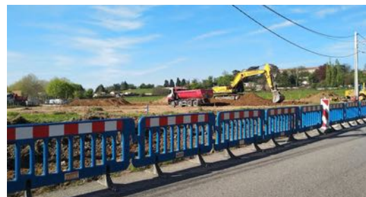
Début des travaux à Saint-Genis-Laval, été 2018
