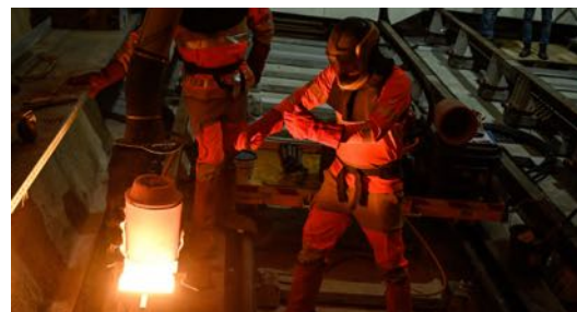
Dernière soudure de voie ferrée, novembre 2022
